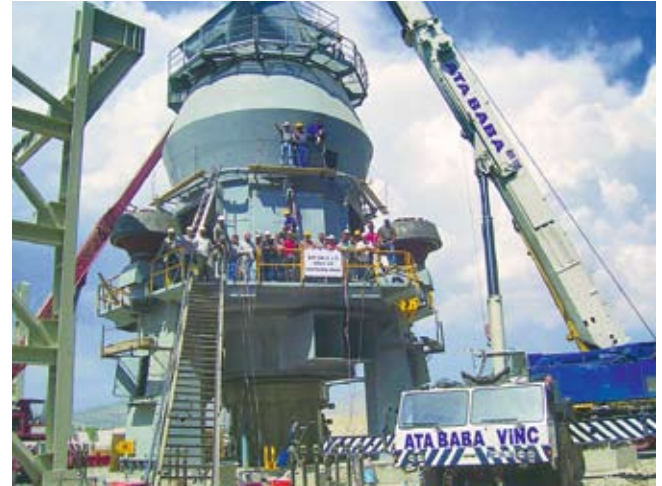
4 Montagefortschritt nach 27 Tagen 4 Progress of erection after 27 days
