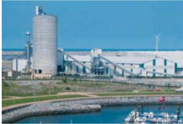
12 Hüttensand-Mahlwerk (Bilbao/Spanien) 12 Slag grinding plant (Bilbao/Spain)
