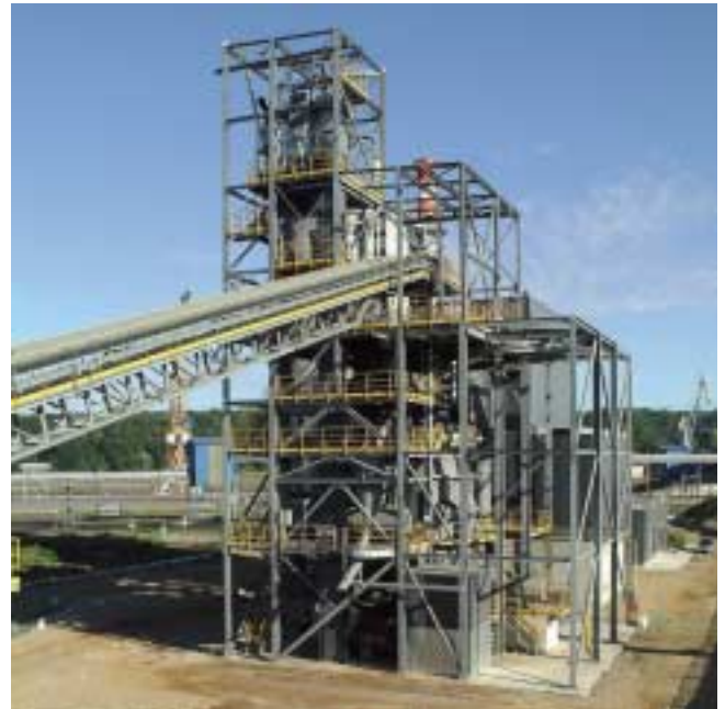
7 Anlage Rouen, Frankreich, LM 35.2+2 7 Rouen plant, LM 35.2+2
